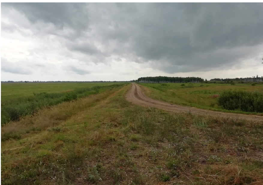
Рис. 2. Дорожная грунтовая насыпь южнее д. Большие Дворцы, Пинский район Брестской области
